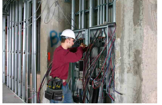
ELEKTRİFİKASYON İŞLERİ ELECTRICAL INSTALLATION WORKS
