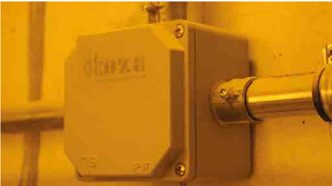
FABRİKA UYGULAMASI - FACTORY / İZMİR
