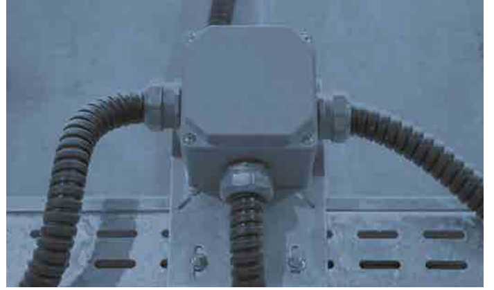
FABRİKA UYGULAMASI - FACTORY / İZMİR
